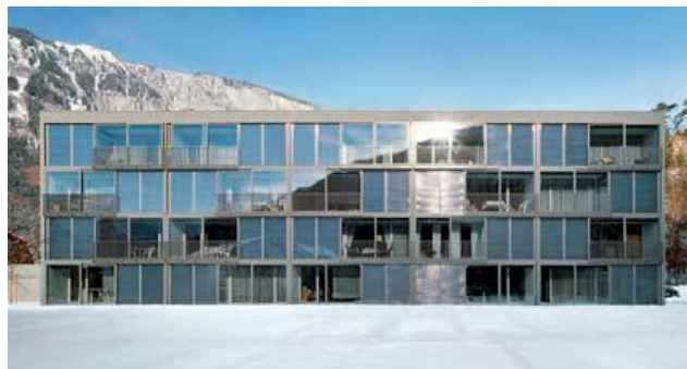
شکل ۱۲: نمای جنوبی مجتمع مسکونی، سوئیس، شیشه های عایق سازی شده با مصالح PCM (Ritter, ۲۰۰۷)
