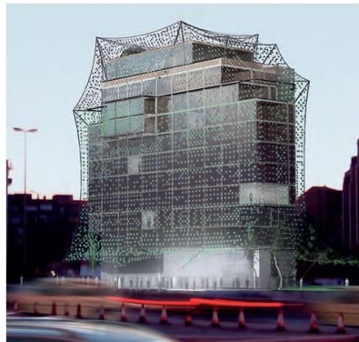
شکل ۱۱: هتل هبیتات، اسپانیا (Ritter, 2007)
