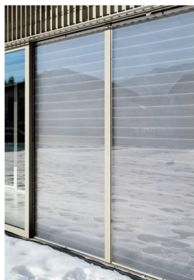
شکل ۱۷: جزئیات پنجره های نما، در وضعیت غیر شارژ (Ritter, ۲۰۰۷)
