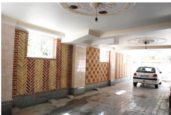
تصویر شماره ۱۴: نقش دل نشین آجری سربایه سازی، هره بندی، نقوش حصیری، نقوش جناغی و... نمای داخلی پارکینگ ساختمان یادشده؛ مأخذ: نگارندگان
