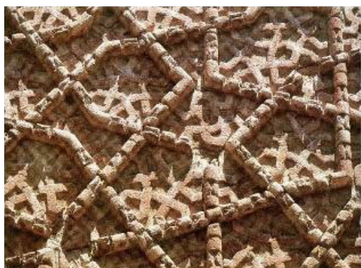
تصویر شماره ۶: نقوش گود و برجسته گرد (کند دوینج سرمه‌دان) آجرقرمز «پیش‌بُر» جزئیات از تصویر قبل؛ مأخذ: MARKUS HATTSTEIN AND PETER DELIUS ISLAM ART AND ARCHITECTURE
