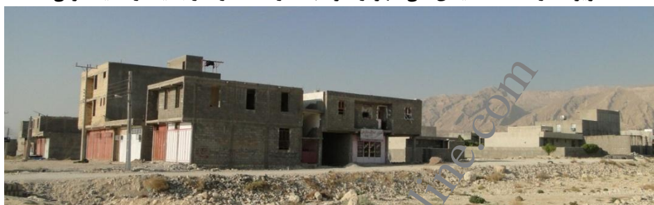
تصویر شماره 44-2: سیمای کلی شهر از نظر طبقات و ساخت و ساز جدید در ناحیه شرقی
