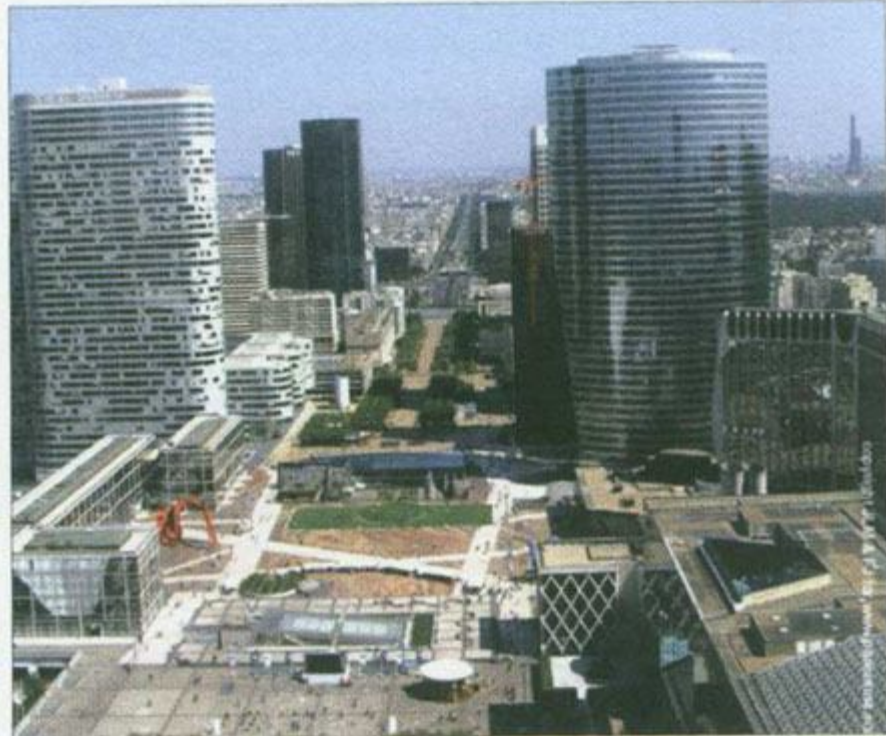
تصویر ۲۵ (الف) - اطراف و مابین ساختمان‌های عظیم به فضای شهری اختصاص می‌یابد.
