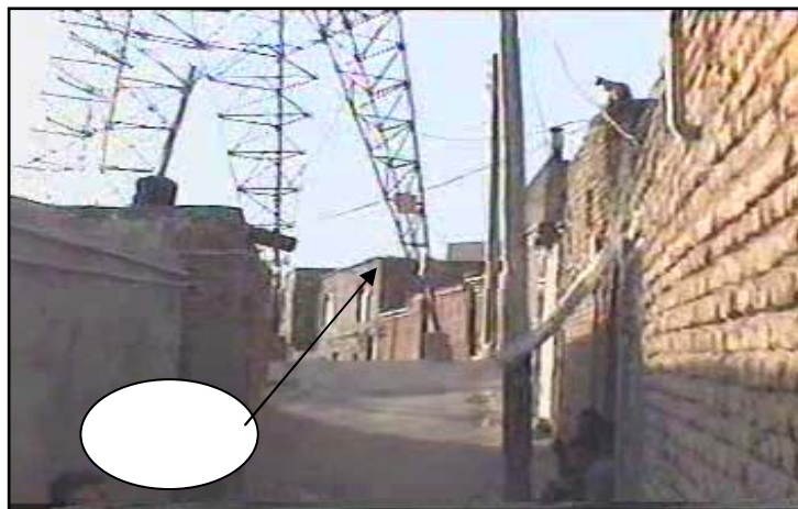
شکل ۵: واحدهای مسکونی واقع شده در حریم دکل فشار قوی (سیلاب)
