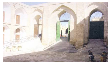
نمایی از جبهه شمالی (ورودی اصلی مسجد)
